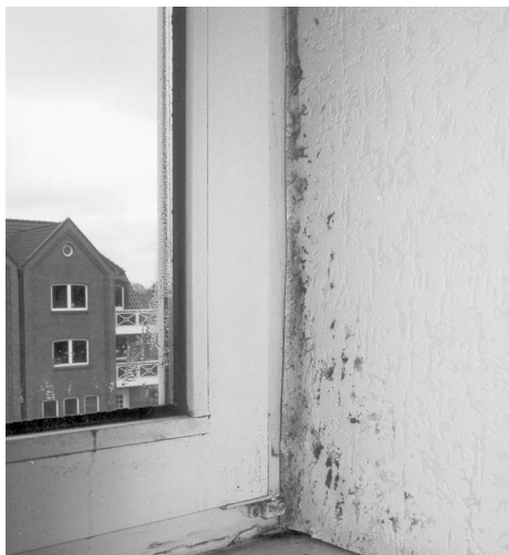
Abb. 4.12: Schimmelpilzdreieck an der Leibung oberhalb der Fensterbank
