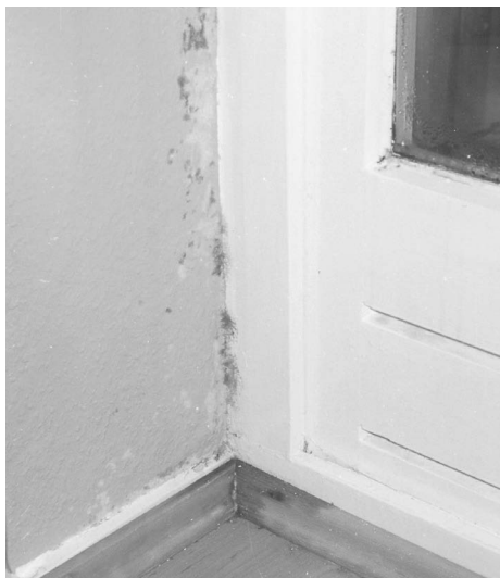
Abb. 4.12: Schimmelpilzdreieck an der Leibung oberhalb der Fensterbank
