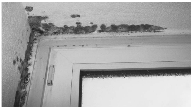
Abb. 4.14 bis 4.16: Linear scharfkantiger Befall, umlaufend entlang des Blendrahmens: Wärmebrücke in der Konstruktionsfuge des Fensteranschlusses
