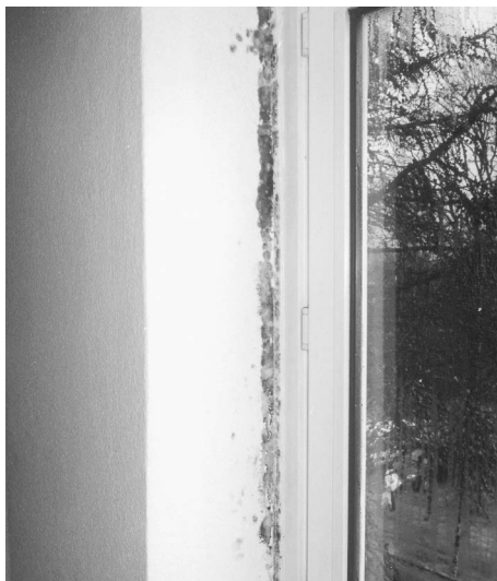
Abb. 4.14 bis 4.16: Linear scharfkantiger Befall, umlaufend entlang des Blendrahmens: Wärmebrücke in der Konstruktionsfuge des Fensteranschlusses
