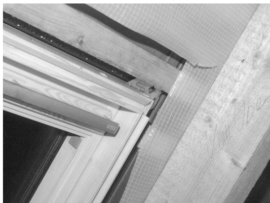
Abb. 4.177 und 4.178: Der Anschluss der Unterspannbahn an das Dachflächenfenster ist nicht regensicher hergestellt.
