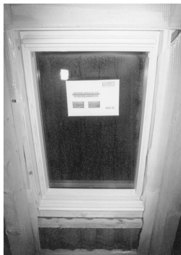
Abb. 4.177 und 4.178: Der Anschluss der Unterspannbahn an das Dachflächenfenster ist nicht regensicher hergestellt.
